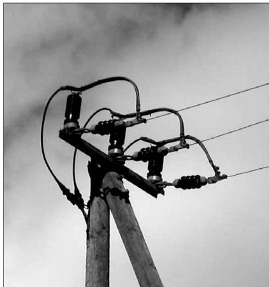
Bilder links: Flügel eines durch Stromschlag getöteten Uhus; gefährlicher Mittelspannungsmasten. Bilder rechts: Um den Stromschlag zu verhindern, werden die stromführenden Elemente näher als 60 cm zum Sitzplatz isoliert.
